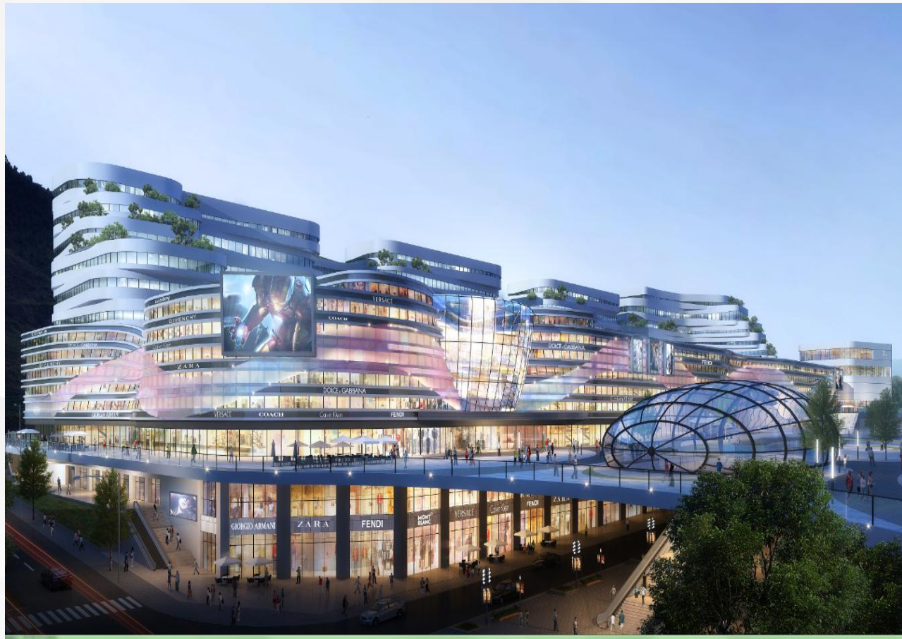
云南分公司-昭通中心城市温泉旅游开发项目
